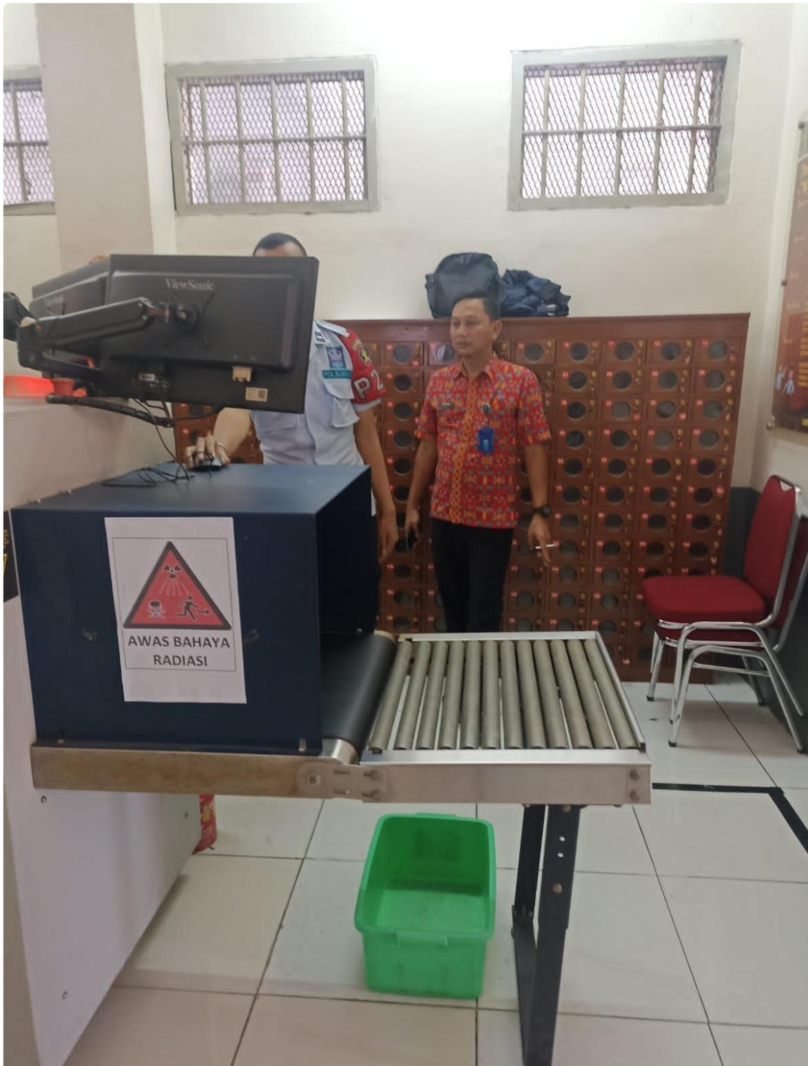
Pemeliharaan ini meliputi control box, power distribution, body, dan source pada mesin x-ray, serta dilakukan pemasangan garis aman dan tanda bahaya radiasi.
